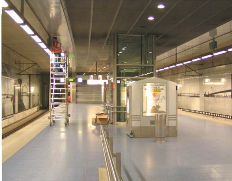
Montage an der abgesperrten Bahnsteig-Kante im Bahnhof „Meiderich“
