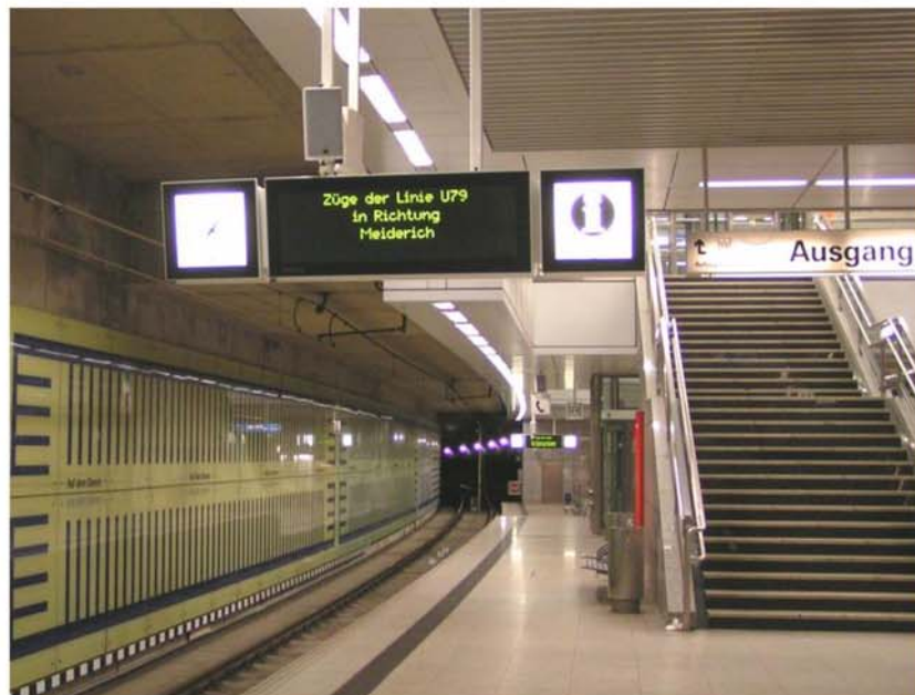
Bahnhof „Auf dem Damm“ mit K&F Systemen am Zugzielanzeiger
